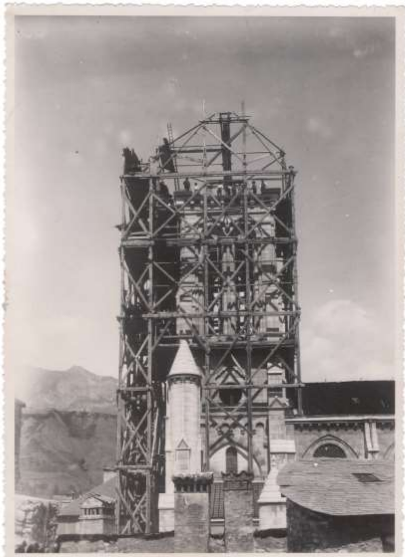
Le clocher en construction dans les années 1890.
